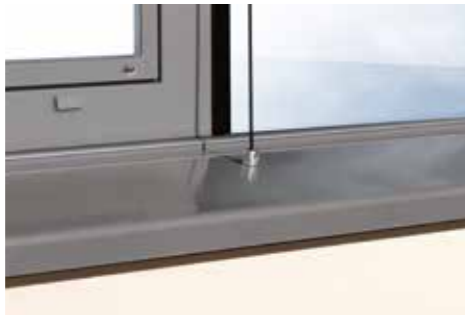
Verdeckte Seilabspannung bei FixFrame Blue Vision fest unter der Fensterbank verankert
