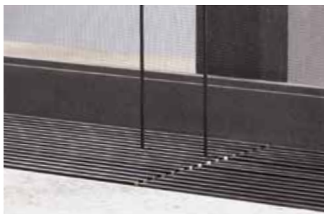
Verdeckte Seilabspannung bei neuem Entwässerungsschacht
